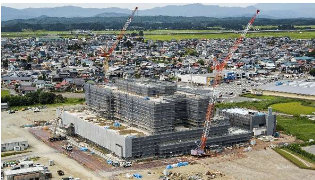
工事現場の写真（令和4年8月29日撮影）
